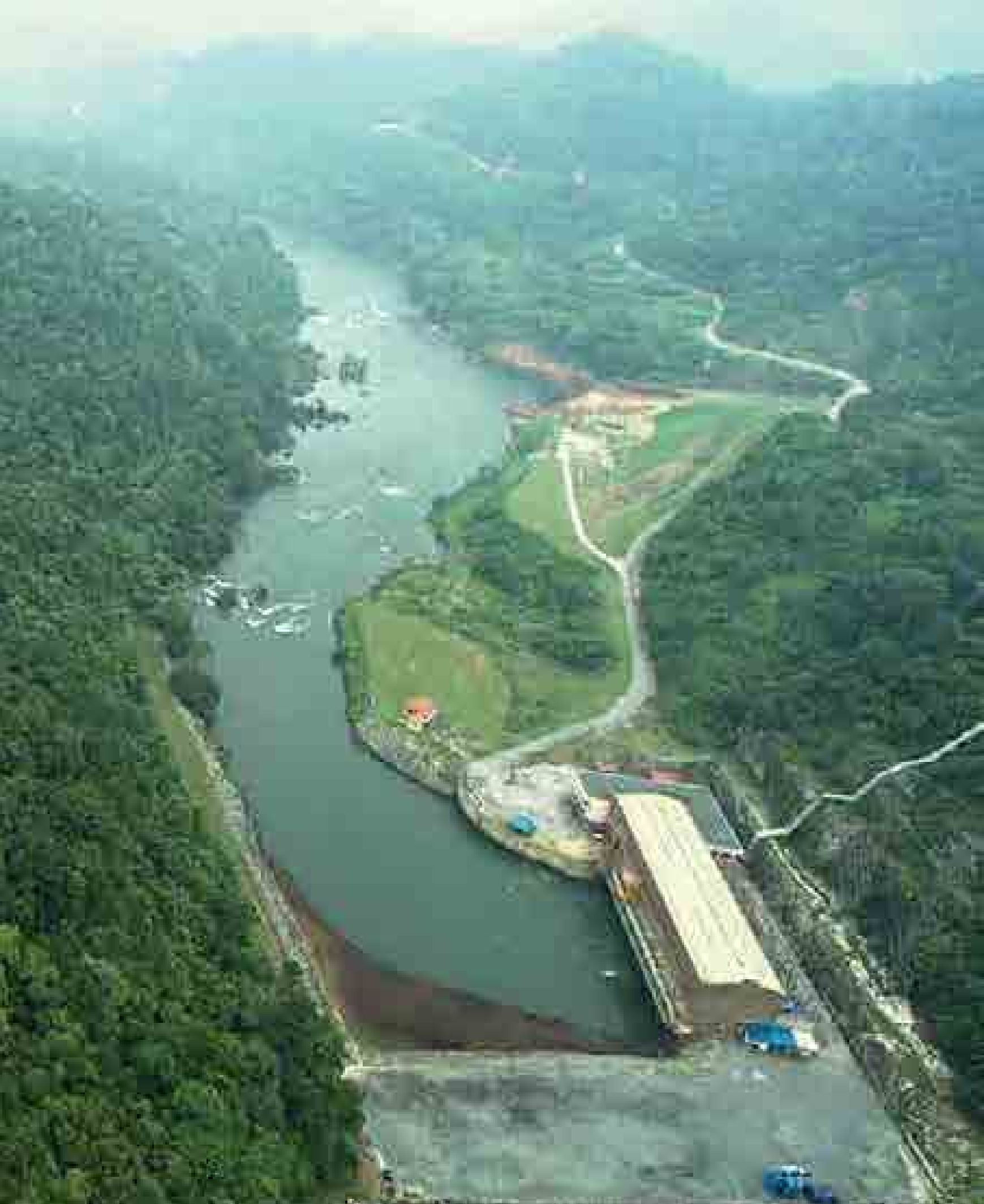
Temenggor Dam, Gerik, PERAK
